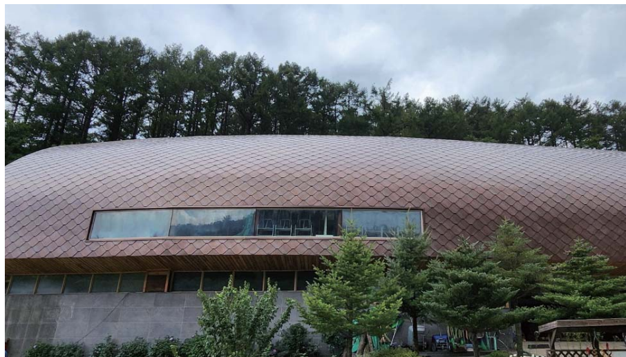
산림청연수원 숲체원 대강당 강원 횡성군 둔내면
