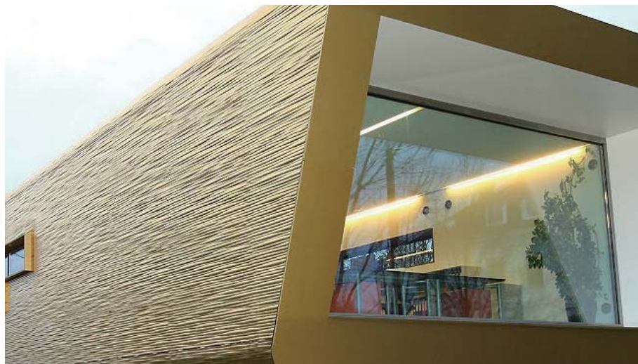
3D 웨이브 강판 외국 시공 사례
