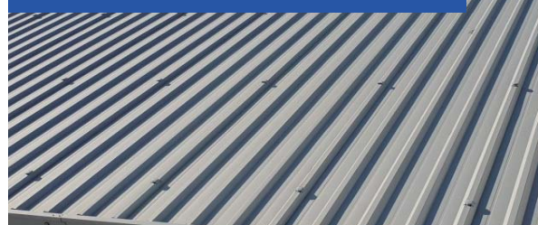
덧방용 강판 시공 후 마감해진 모습
